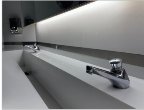
รูปที่ ๒.๑๔ การติดตั้งอุปกรณ์เพื่อป้องกันการสูญเสีย
