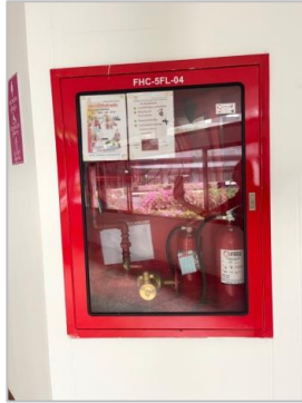
รูปที่ ๓.๘ การติดตั้งอุปกรณ์ดับเพลิงและระบบสัญญาณแจ้งเตือน
